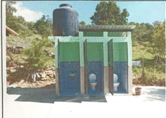
Foto 5: Reparación de servicios sanitarios y cambio de accesorios, lava manos, Rotoplast y Tubería PVC, finalizado en su totalidad
