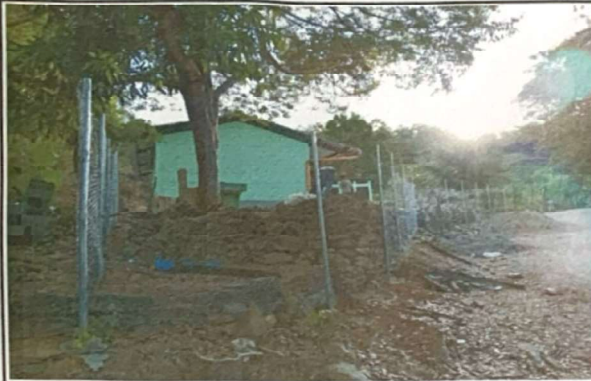
Foto 1: Proceso de cercado con malla en el predio de la escuela, finalizado en su totalidad.
